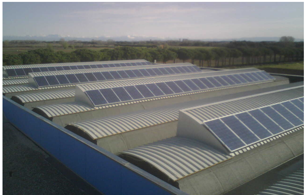
Installazione sopra la copertura a falde 30 Kw
