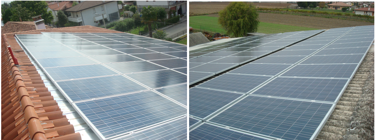
Installazione integrata nella copertura a falde 20 Kwp
