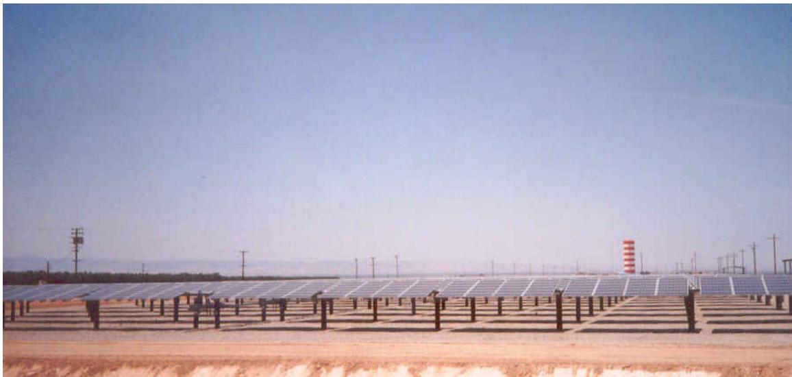
Campo fotovoltaico a inseguimento solare da 1 Mw
